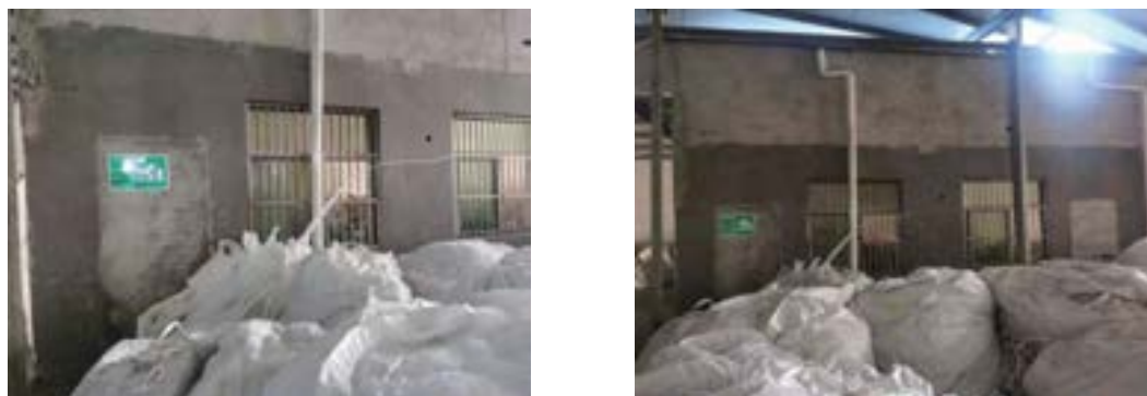
图 4.6.2-1 建设单位一般固废库现状图
